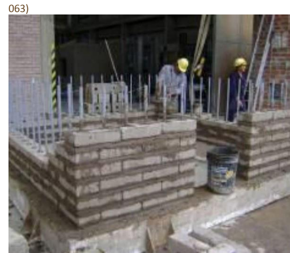
Figura 063 Construcción de la mitad inferior del módulo con refuerzo de PVC. Villon & Castillo (2013).
