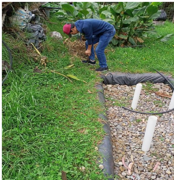
Figura 4. Colocación de las estacas para el trazo del largo y ancho del invernadero.
