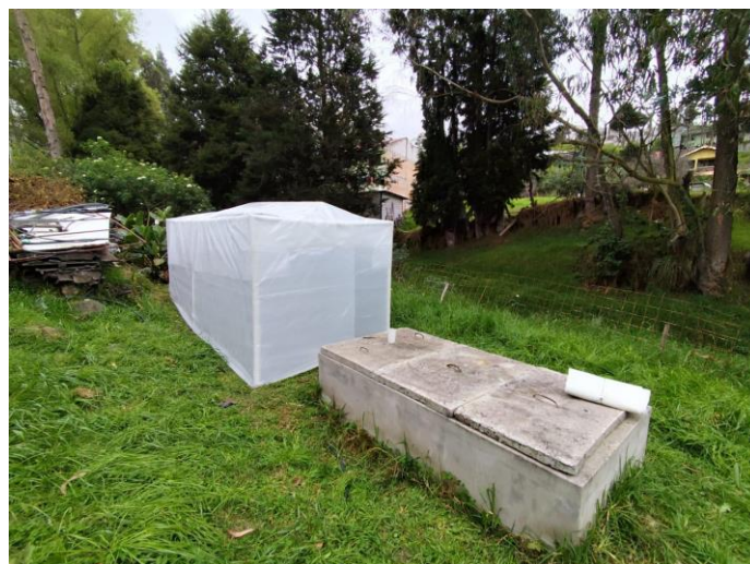
Figura 7. Recubrimiento de la estructura con plástico de polietileno.
