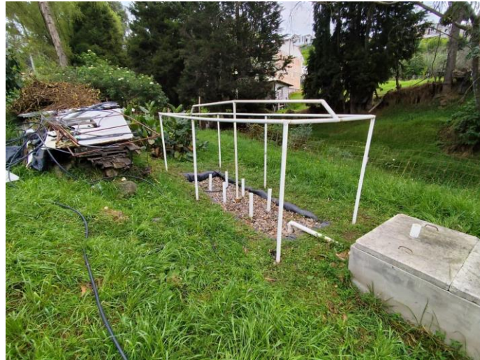
Figura 6. Soportes del invernadero (Laterales, largueros, techo).
