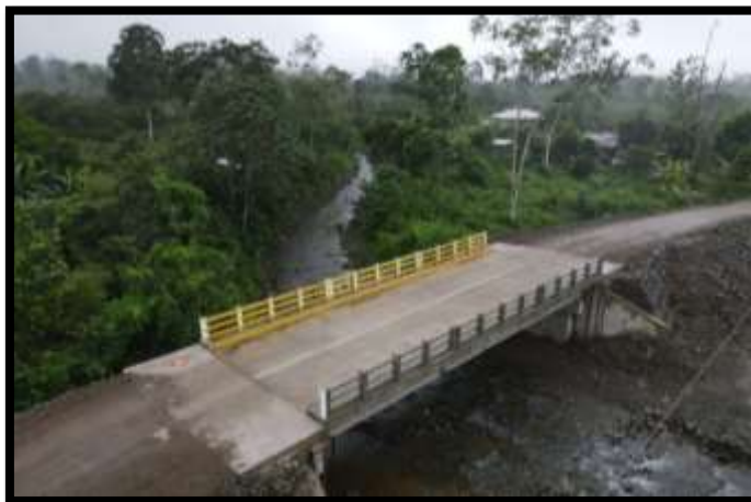
Figura 6. Puente (Fuente: Prefectura de Azuay)
