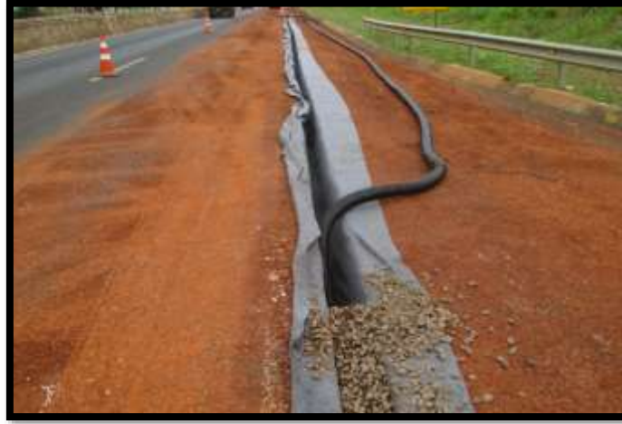
Figura 4. Subdrenes (Fuente: Nóbrega Pimenta Constructora)
