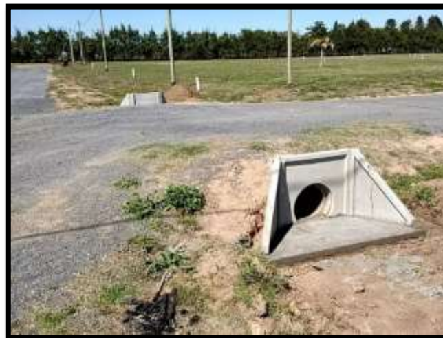
Figura 5. Alcantarilla con cabezal y alas (Fuente: Agroads)
