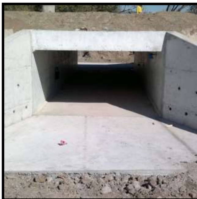
Figura 7. Puente cajón (Fuente: García & Bodán)
