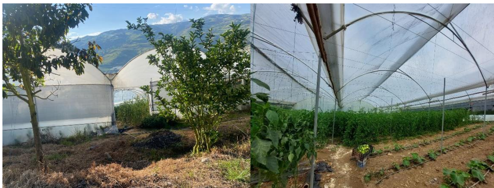
Vista exterior y vista panorámica interior respectivamente del segundo invernadero, en el cantón Guachapala.
