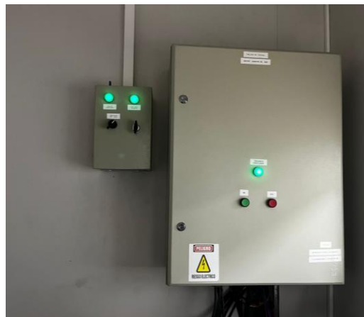
Figura 10: Generador de alta tensión Fuente: Autores
