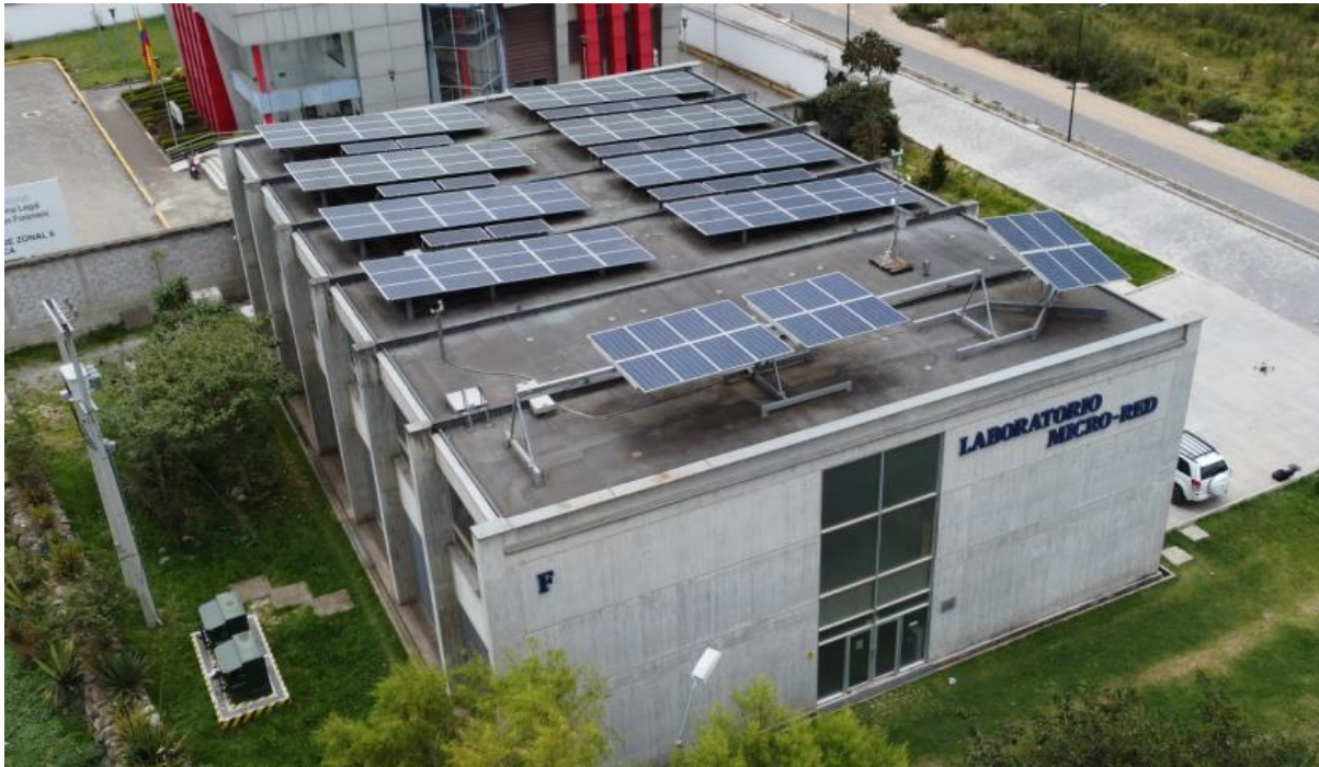
Figura 20. Disposición de arreglos fotovoltaicos existentes en el Laboratorio de Micro-Red [51].
