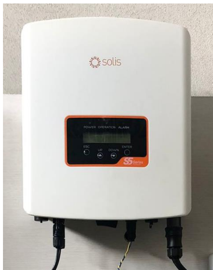
Figura 2–5: Convertidor de potencia Solís. Fuente: [Propia].
