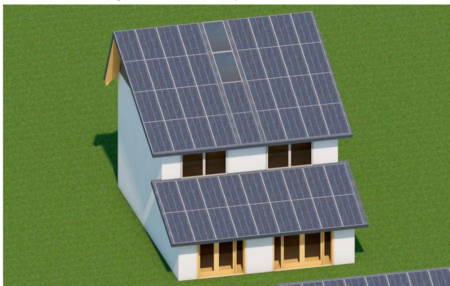
Figura 7 - Instalación de tecnologías BIPV + BISTw en probeta de Modelo C
